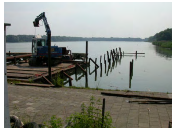
Aanleg nieuwe steiger en uitzicht over de duikstek
